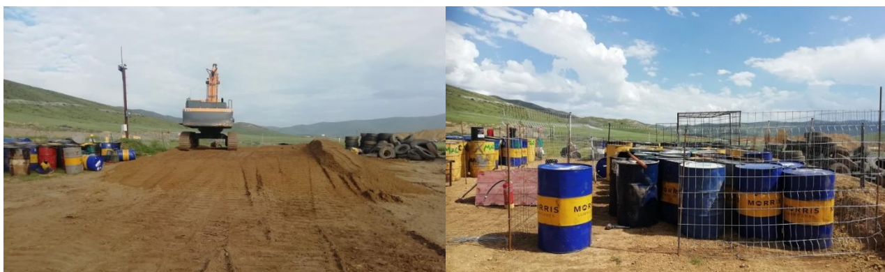
Зураг.20 Баяжуулах үйлдвэрийн хаягдлаар дэвсэлт хийж ажиллаа.
