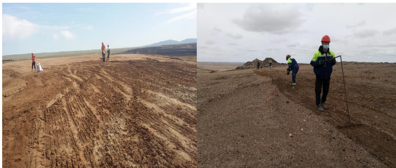
Нөхөн сэргээлтийн 4.5 га талбайд үрсэлгээ хийж байгаа байдал. Зураг № 15
