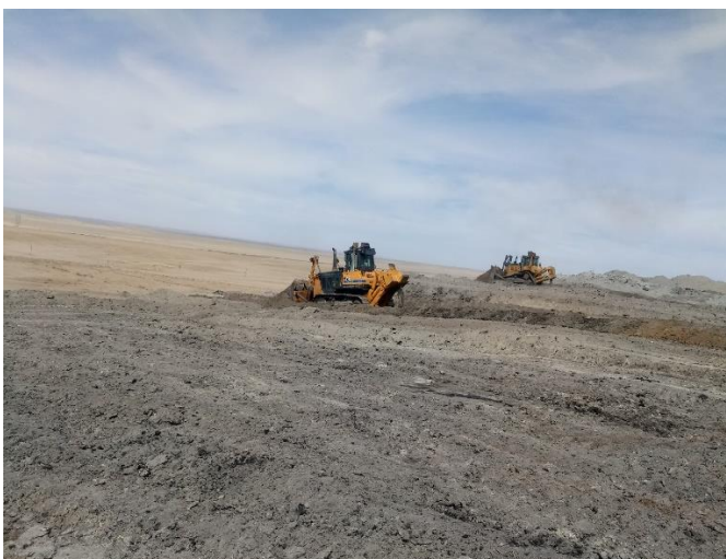
Зураг № 14 2022 оны төлөвлөгөөний дагуу 4.5 га талбайн шимт хөрсний тэгшилгээ хийв.
