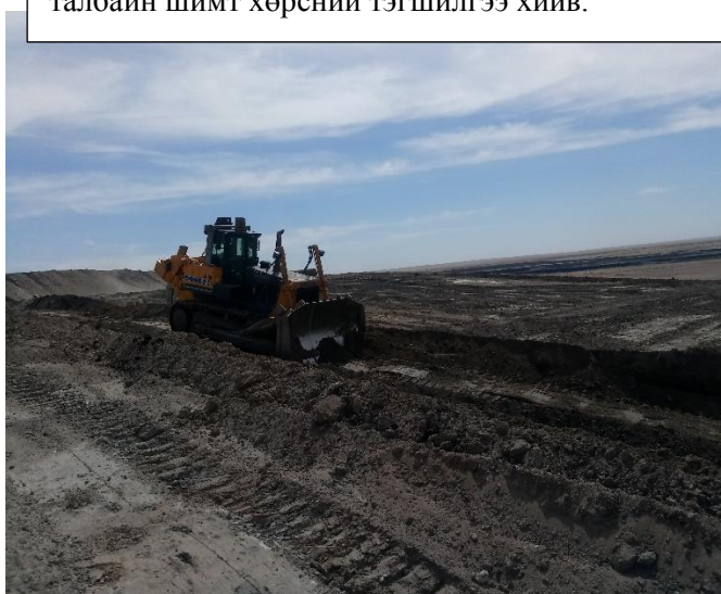
Зураг № 14 2022 оны төлөвлөгөөний дагуу 4.5 га талбайн шимт хөрсний тэгшилгээ хийв.
