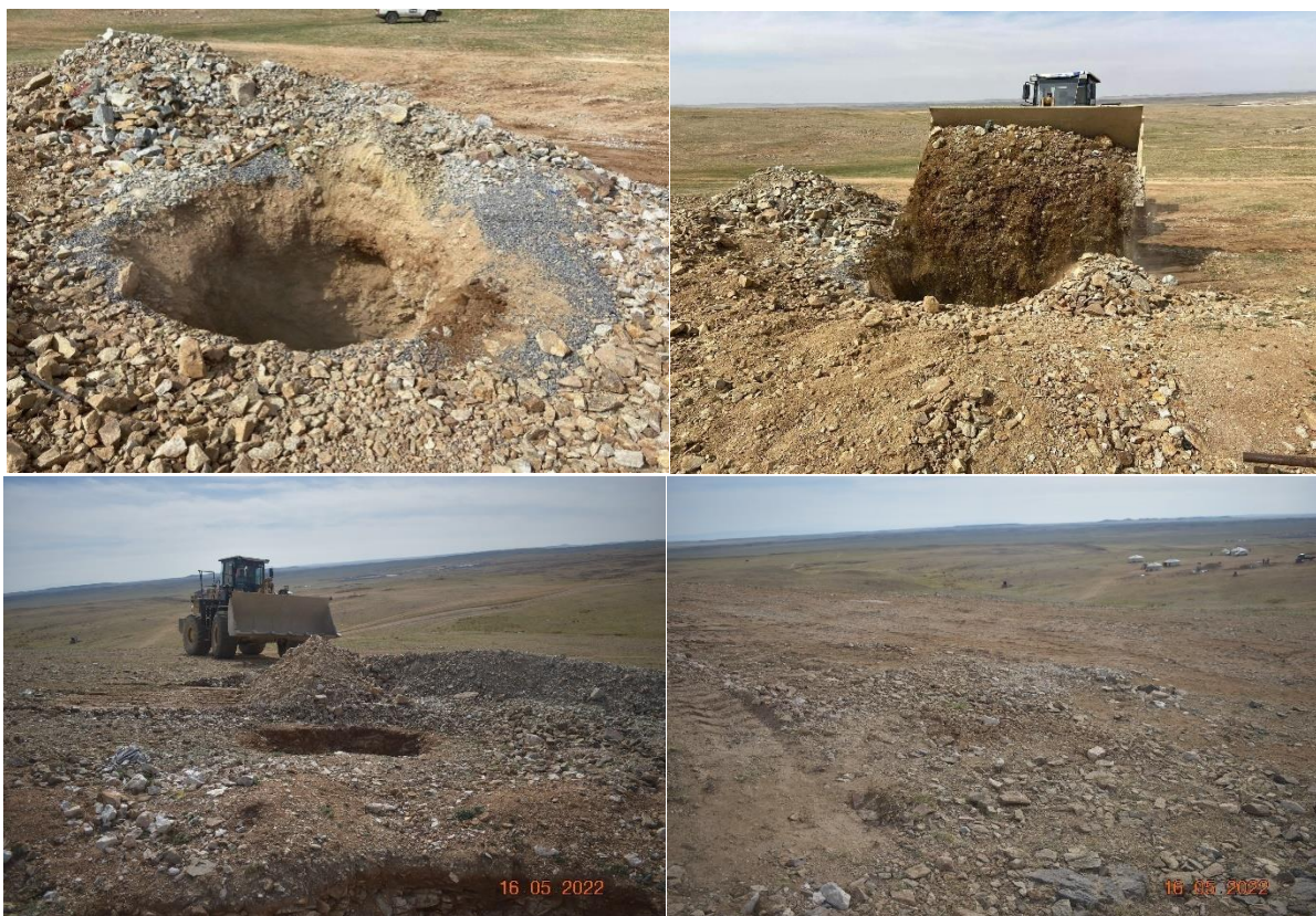
Зураг 19: Техникийн нөхөн сэргээлт хийж буй байдал
