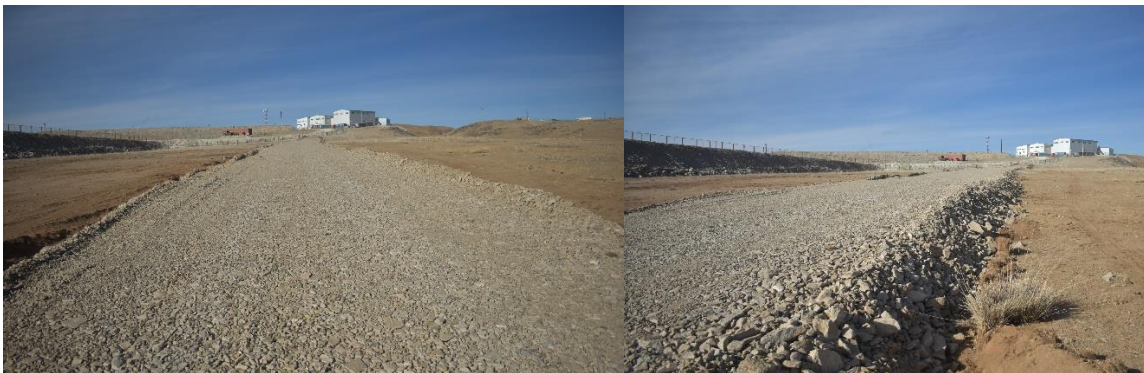
Зураг 12: Баяжуулах үйлдвэрийн тээвэрлэлтийн замыг хайрган хучилттай болгосон байдал
