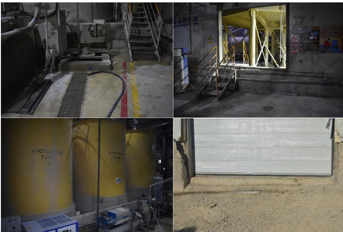
Зураг 29: Баяжуулах үйлдвэрийн уусгалтын танк болон хаалганы өндөрлөгөө, худаг бүхий зумф
