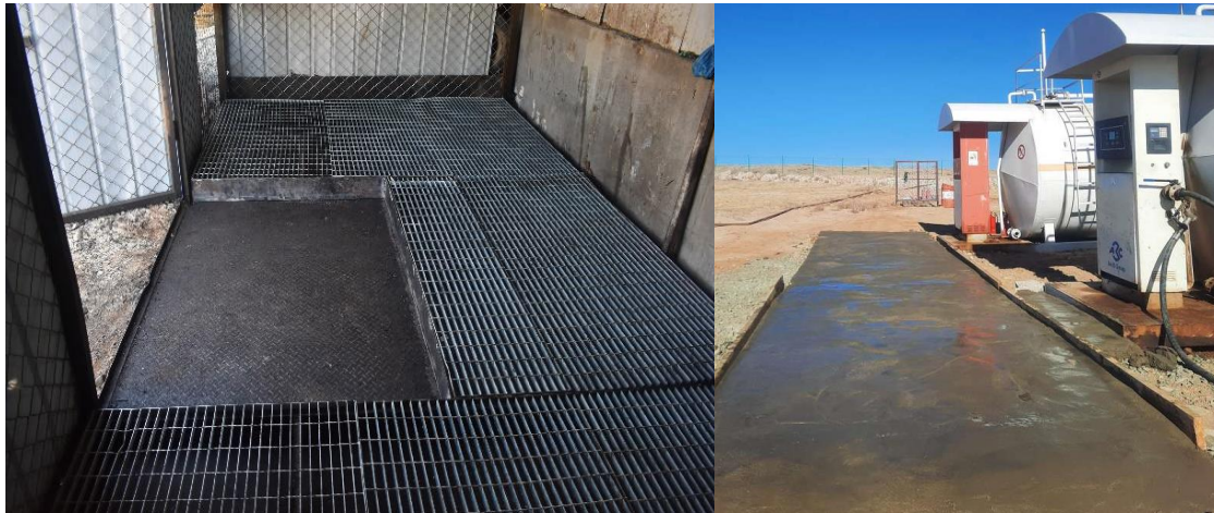
Зураг 13: ШТС-ын түгээгүүрийн суурин хэсгийг хатуу хучилттай болгон тохижуулсан байдал
