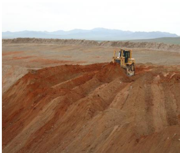
Зураг №12. Дотоод овоолгыг хэлбэржүүлэн тэгшилж буй байдал
