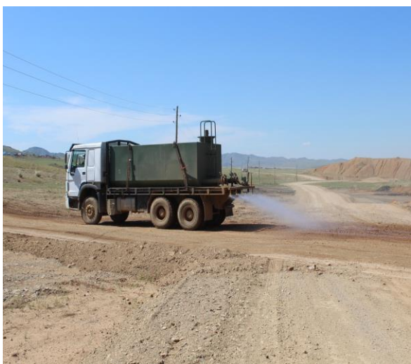
Зураг №7. Усалгааны машин зам талбай усалж буй байдал
