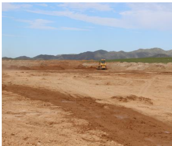
Зураг №12. Дотоод овоолгыг хэлбэржүүлэн тэгшилж буй байдал
