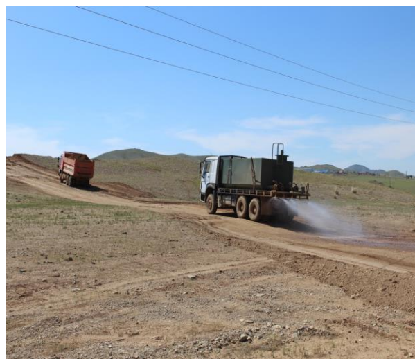
Зураг №7. Усалгааны машин зам талбай усалж буй байдал
