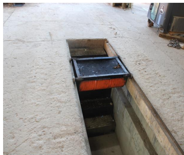
Зураг №5. Засвар үйлчилгээний шалыг цементэлсэн байдал, хаягдал тосны тосгуур
