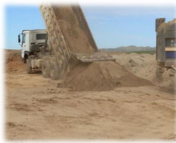
Зураг №13. Нөхөн дүүргэлт хийсэн газар, шимт хөрсний конусан овоолго хийсэн байдал
