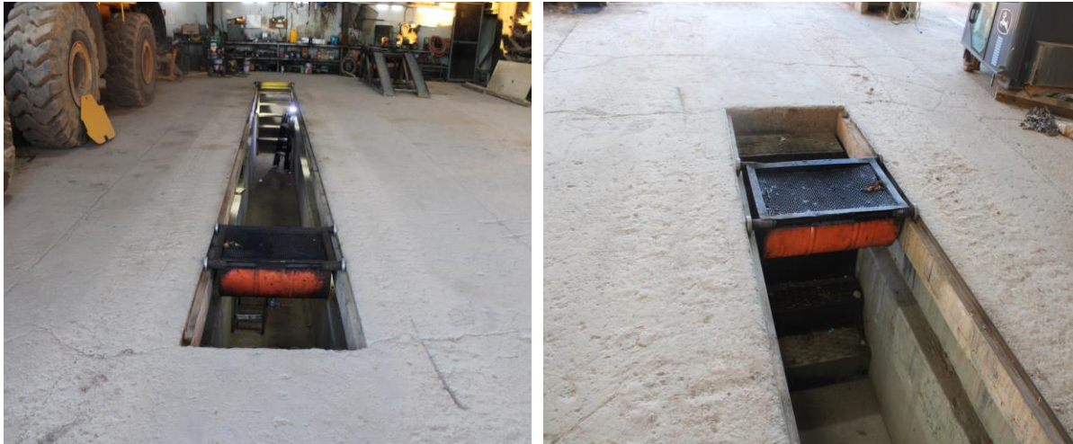
Зураг №5. Засвар үйлчилгээний шалыг цементэлсэн байдал, хаягдал тосны тосгуур
