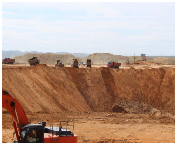
Зураг №11. Дотоод овоолго хэлбэржүүлж нөхөн дүүргэлт хийж байгаа байдал
