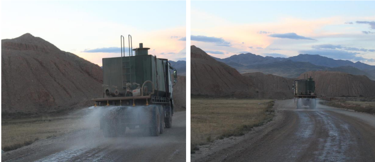
Зураг №7. Усалгааны машин зам талбай усалж буй байдал
