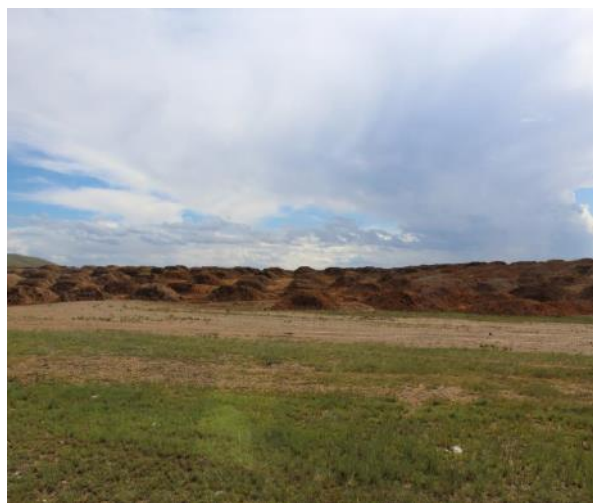
Зураг №13. Нөхөн дүүргэлт хийсэн газар, шимт хөрсний конусан овоолго хийсэн байдал
