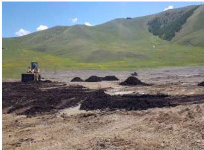
Зураг 11. Шимт хөрсний овоолгоос хөрсийг зөөвөрлөж буй байдал
