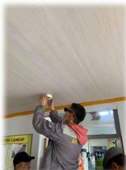
Зураг 9. Галын дохиолол суурилуулж
