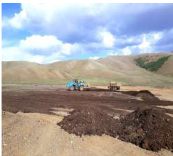
Зураг 12. Шимт хөрсийг талбайд зөөвөрлөн асгаж буй байдал
