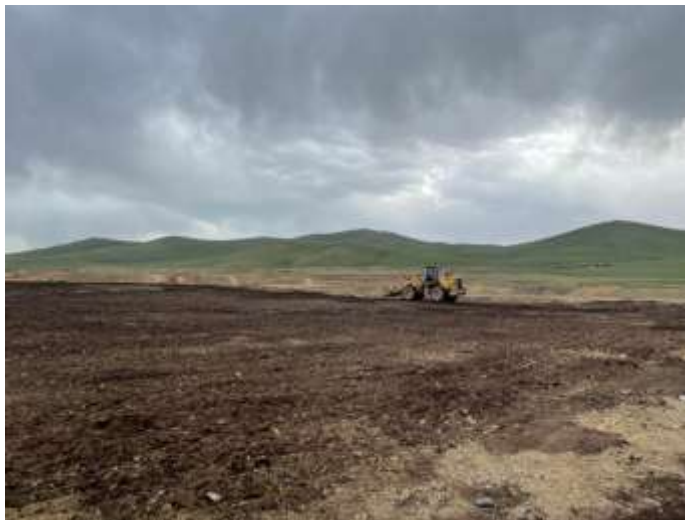
Зураг 12. Шимт хөрсийг талбайд зөөвөрлөн асгаж буй байдал
