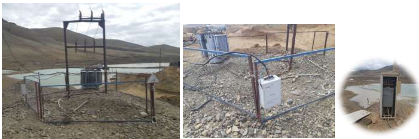
Зураг 46. Цахилгааны монтаж болон аюулгүй байдлыг сайжруулав.
