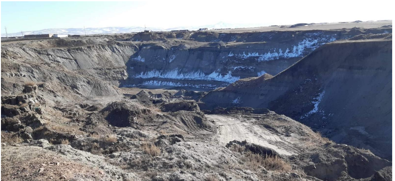
Зураг 3.6. Уурхайн дотоод зам талбайг түрж тэгшилсэн байдал
