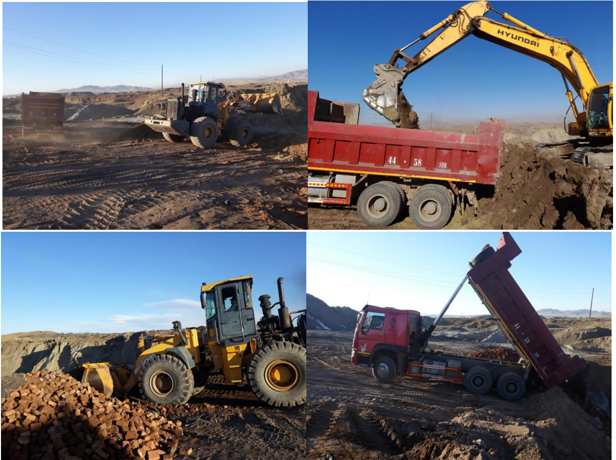
Зураг 3.1. Уурхайн талбайд нөхөн сэргээлт хийж буй байдал
