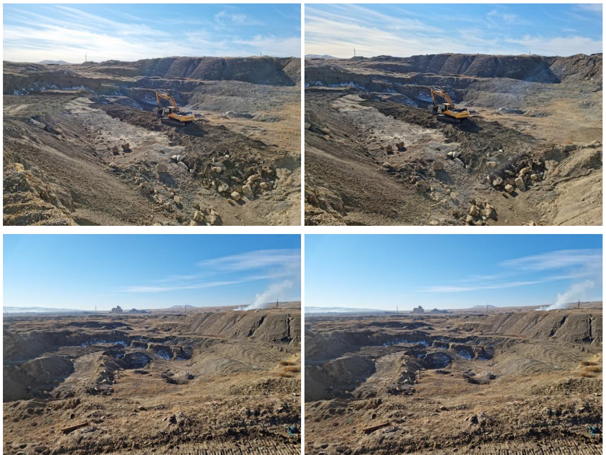
Зураг 3.4. Техникийн нөхөн сэргээлт хийж буй байдал
