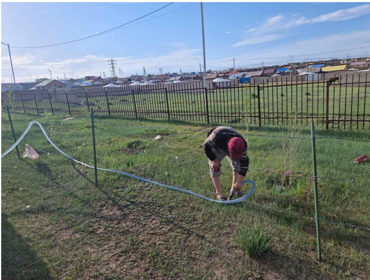
Зураг 3.9. Усалгаа хийж буй байдал
