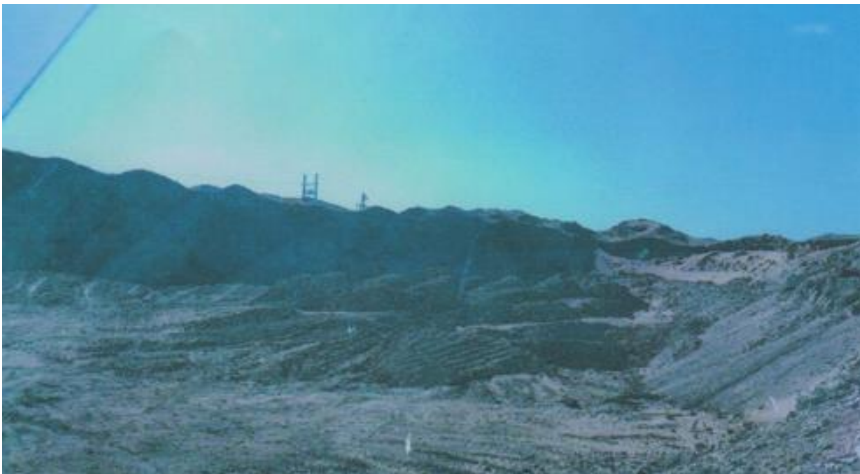
Зураг 3.3. Уурхайн ашиглагдсан талбайд нөхөн сэргээлт хийж буй байдал
