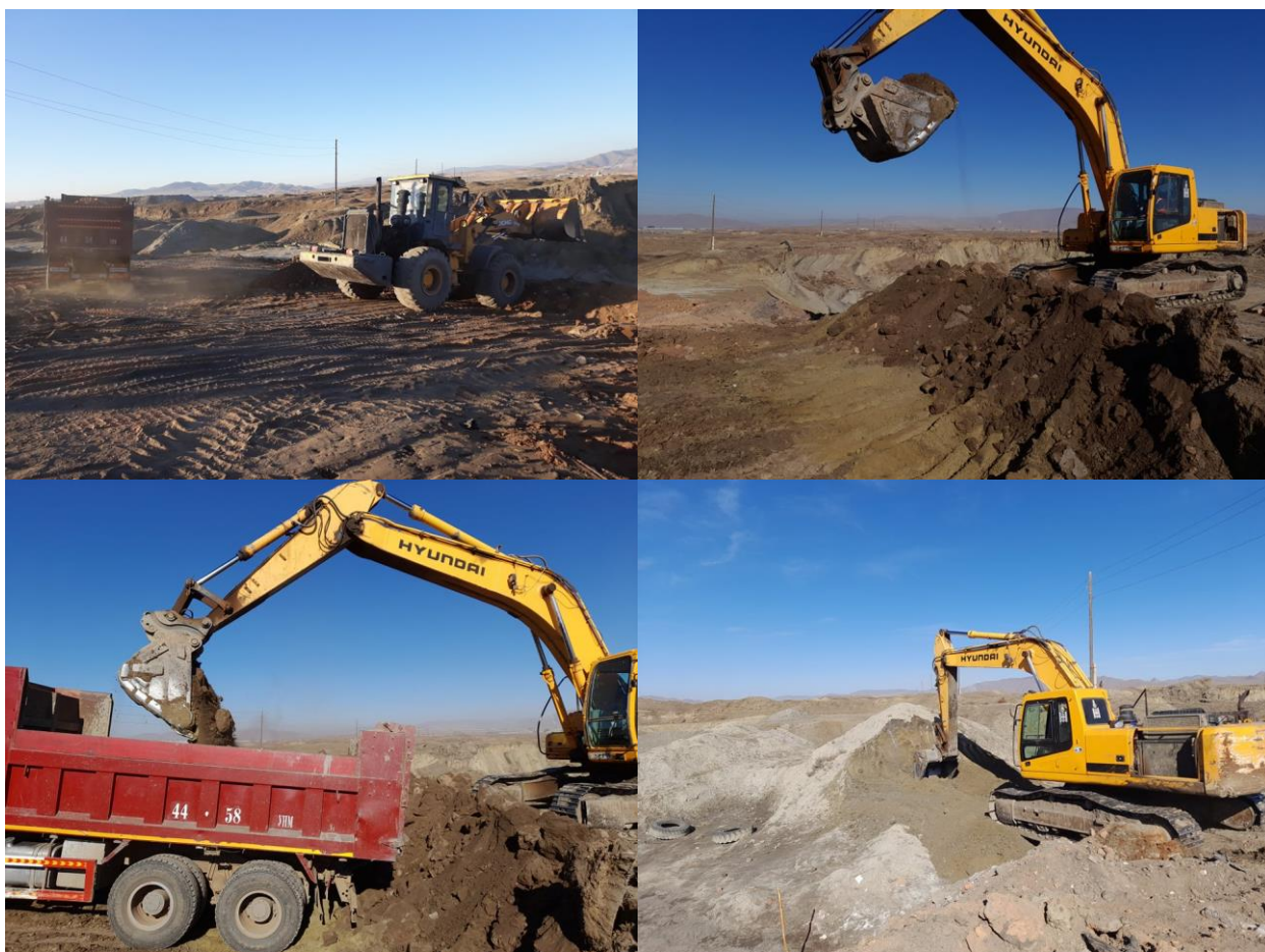
Зураг 3.4. Уурхайн талбайд нөхөн сэргээлт хийж буй байдал-1
