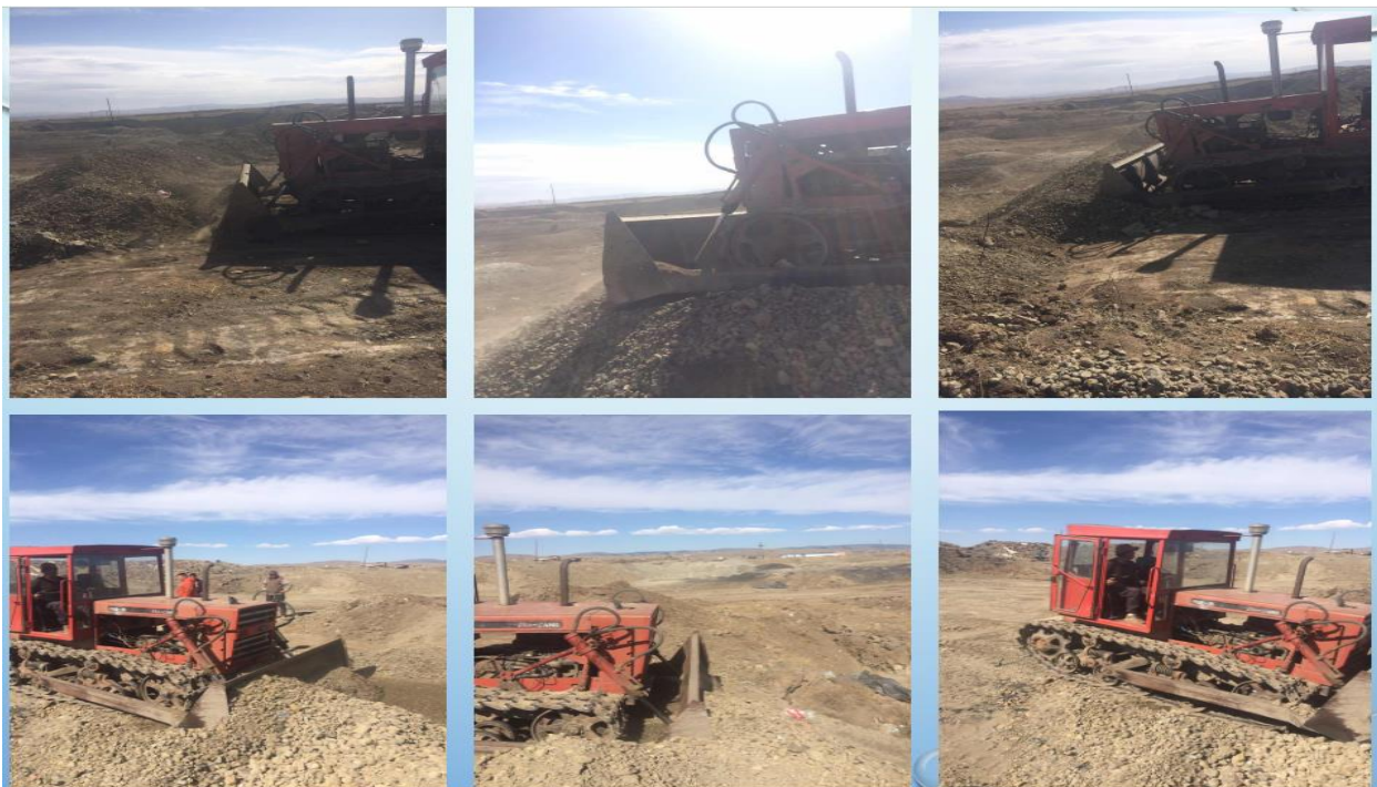
Зураг 3.3. Эвдэрсэн талбайг түрж тэгшилж байгаа нь
