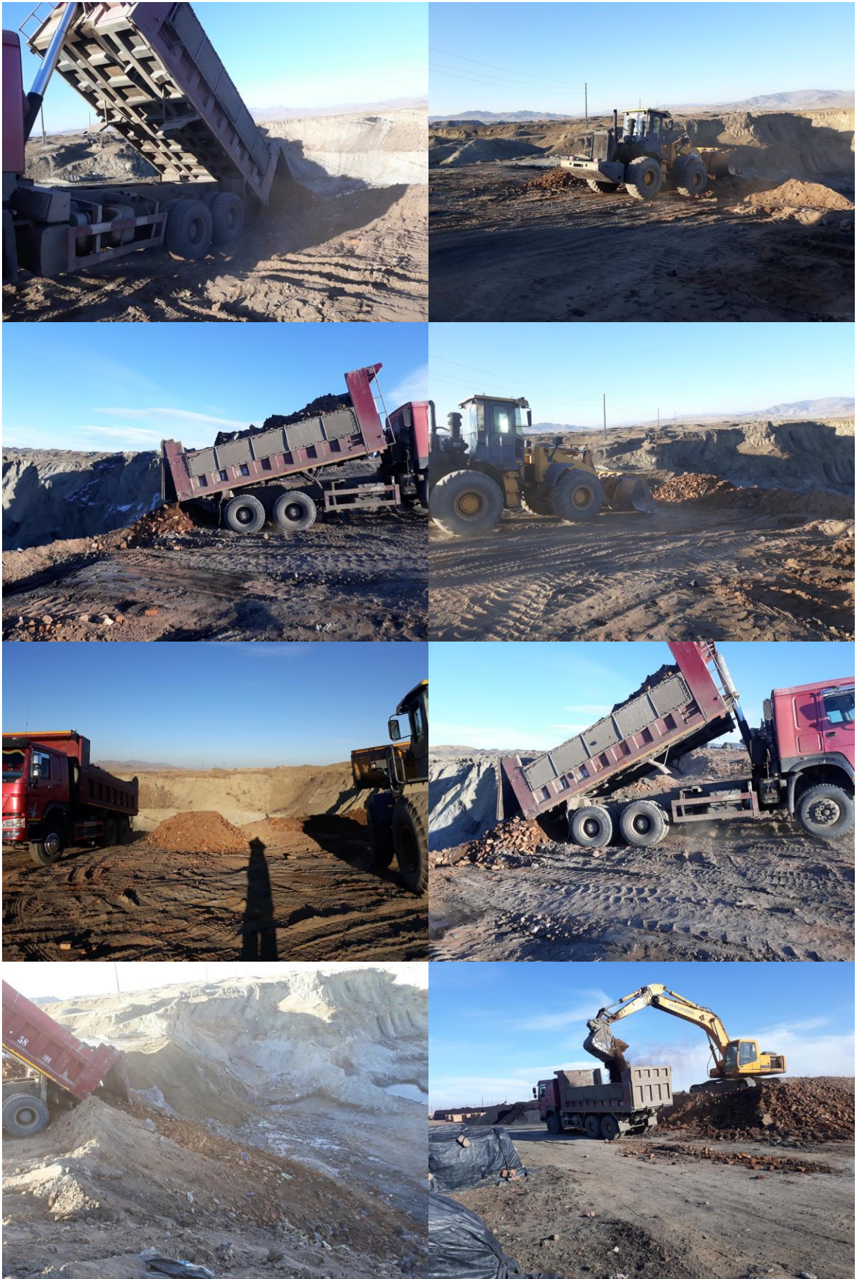
Зураг 3.5. Уурхайн талбайд нөхөн сэргээлт хийж буй байдал-2
