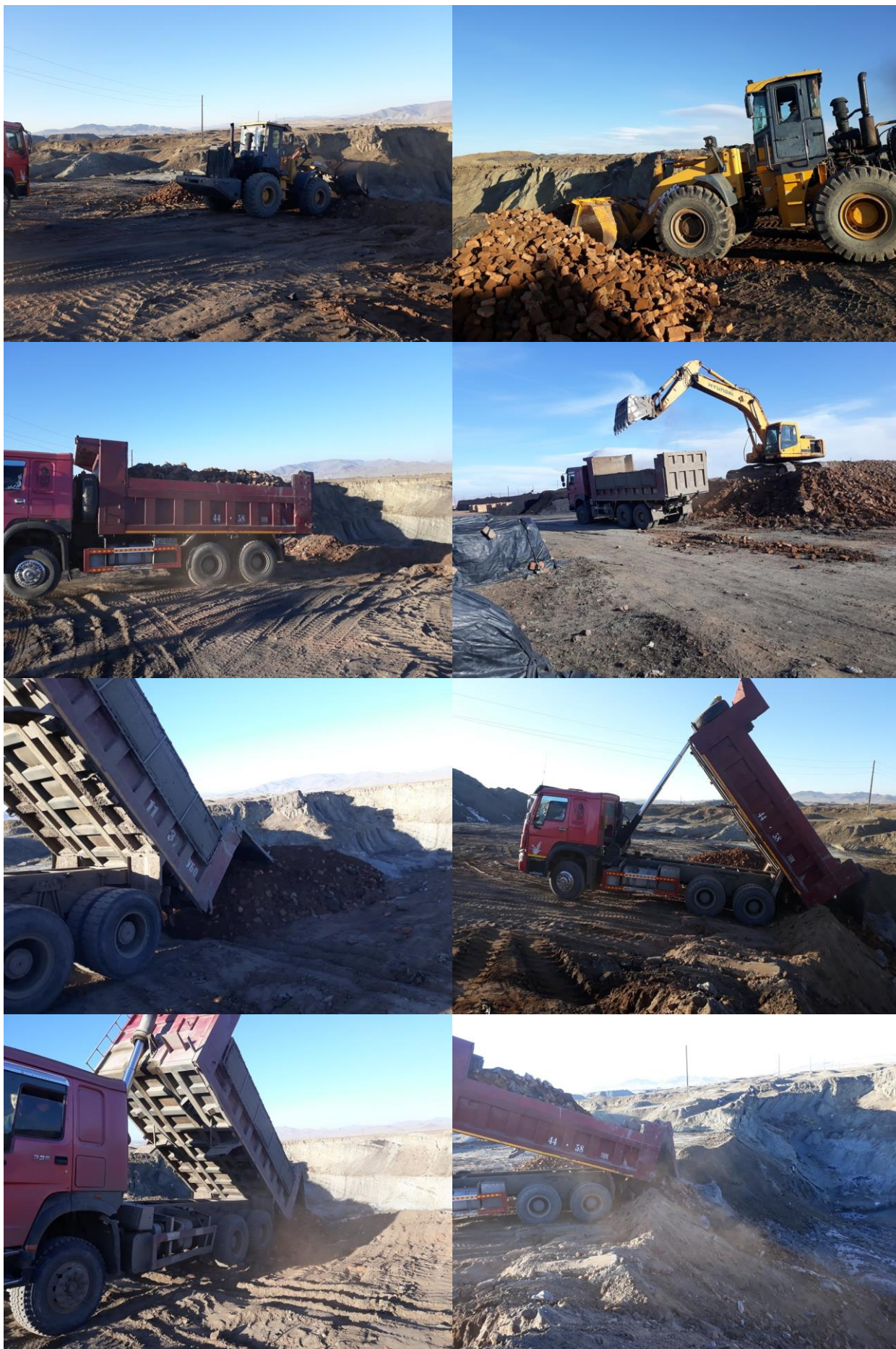
Зураг 3.6. Уурхайн талбайд нөхөн сэргээлт хийж буй байдал-3
