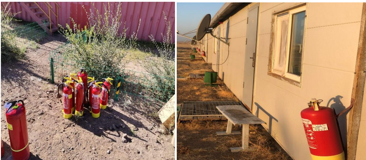
Зураг 24. Үйлдвэрээс ирсэн галын хор суурилуулсан байдал
