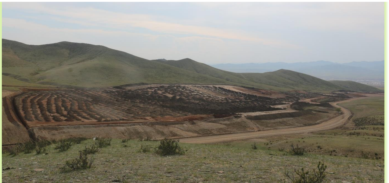
Зураг №.13 Техникийн нөхөн сэргээлт эхэлж байх үе /дотоод овоолгоор дүүргэлтийн ажил хийгдэж байна./
