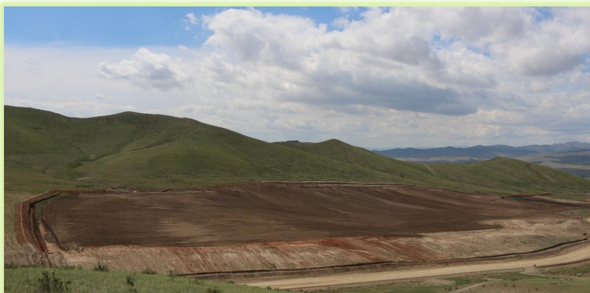
Зураг №.16 Автогрейдер, Бульдозероор тэгшилж хэвгийжүүлэн биологийн нөхөн сэргээлт хийхэд бэлэн болсон талбай.
