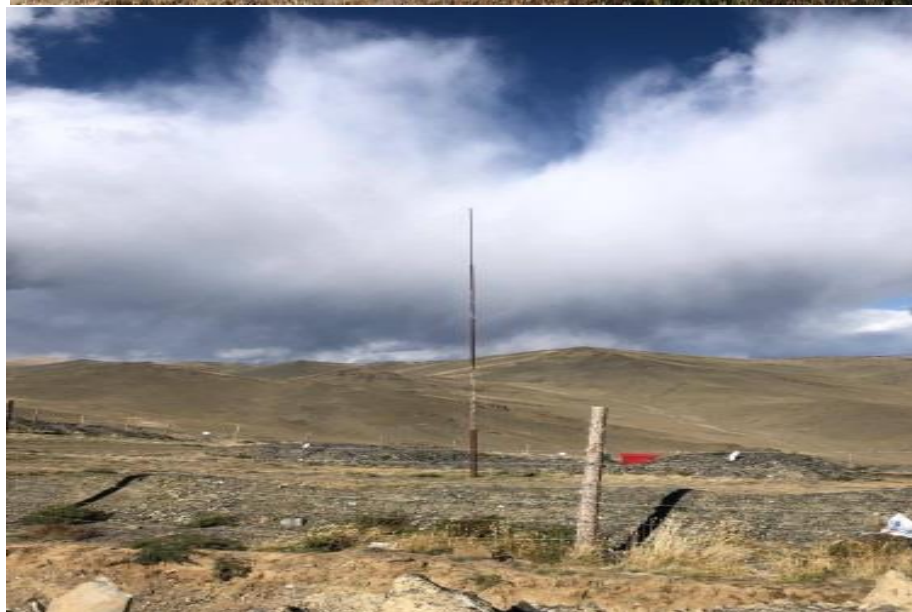
Фото зураг 13. Аянга зайлуулагч хийсэн байдал
