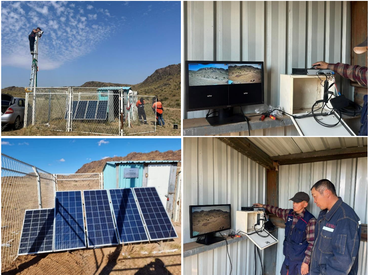
Зураг 22: Нэмэлт нарны толь болон хяналтын камер суурьлуулах үеийн фото зураг
