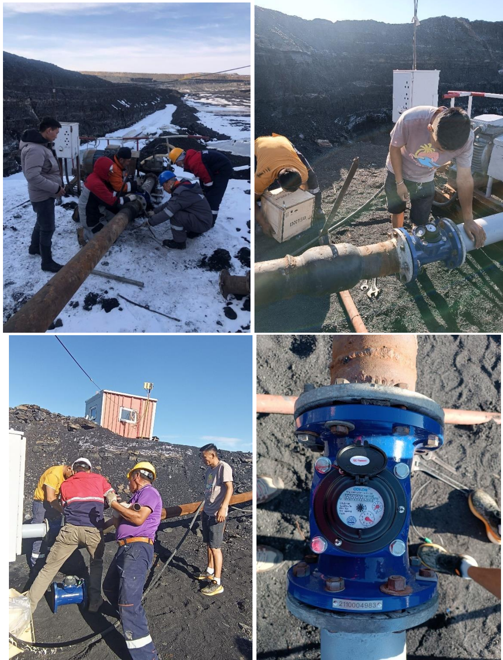
Зураг 11: Шүүрлийн усны насос тоолуур суурьлуулж буй нь
