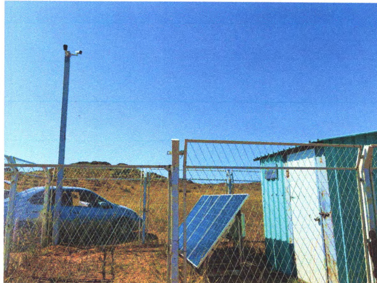
Хяналтын камера суурьлуулж буй ажлын явц
