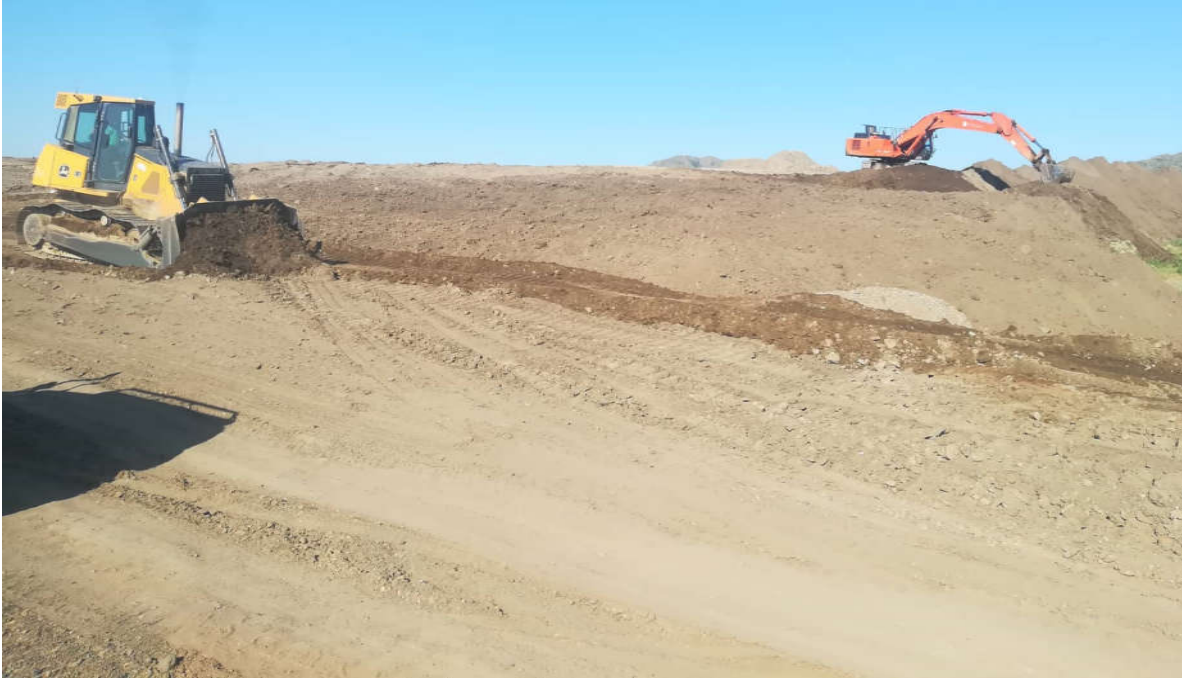
Зураг. Хэлбэржүүлэн тэгшлэлт хийж буй байдал
