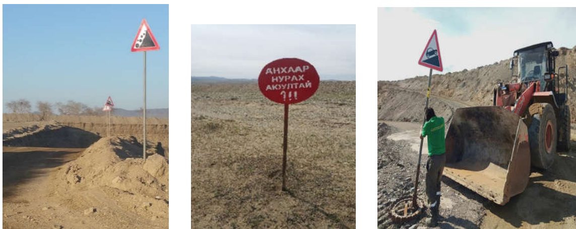
Зураг. Замын тэмдэг, тэмдэглэгээ байршуулсан байдал
