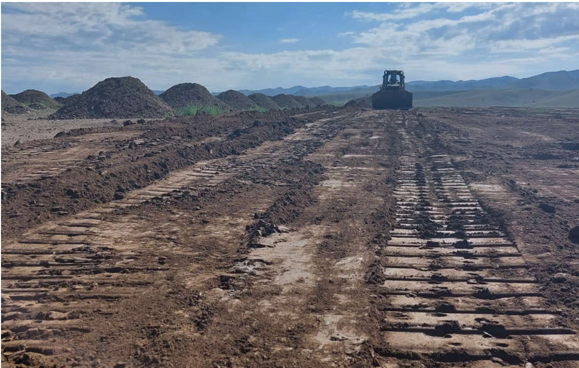
Зураг. Шимт хөрсөөр хучилт хийж буй байдал
