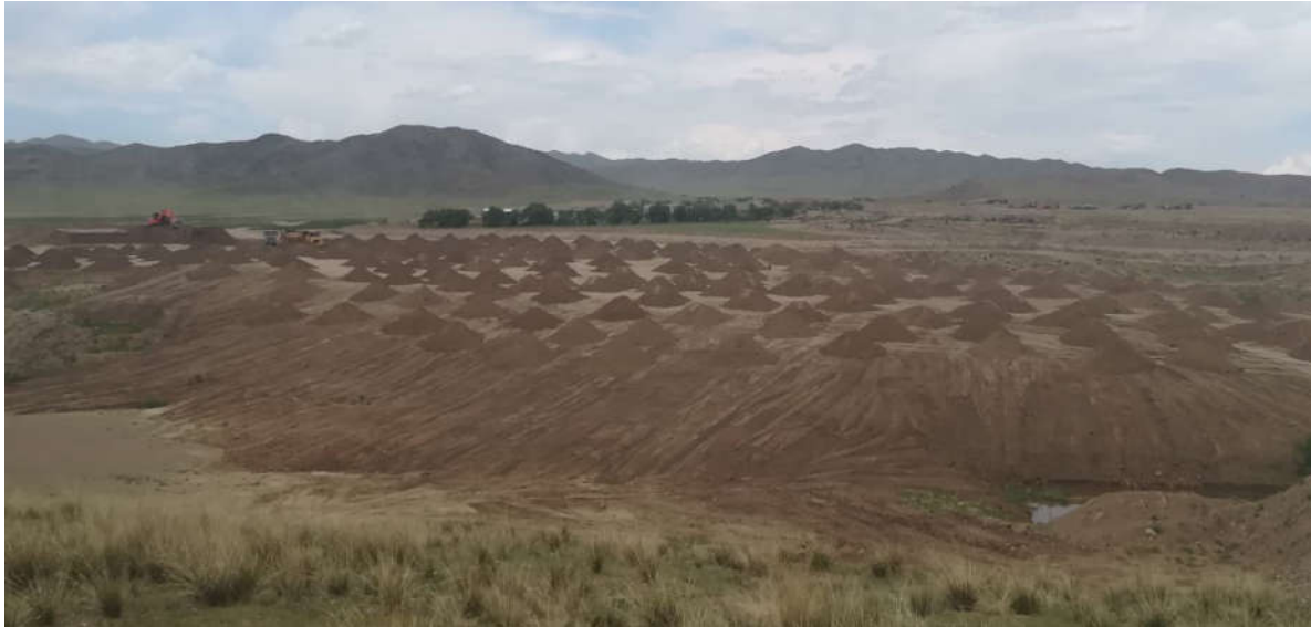
Зураг. Техникийн нөхөн сэргээлт хийж, хар хөрсөөр хучилт хийж буй байдал
