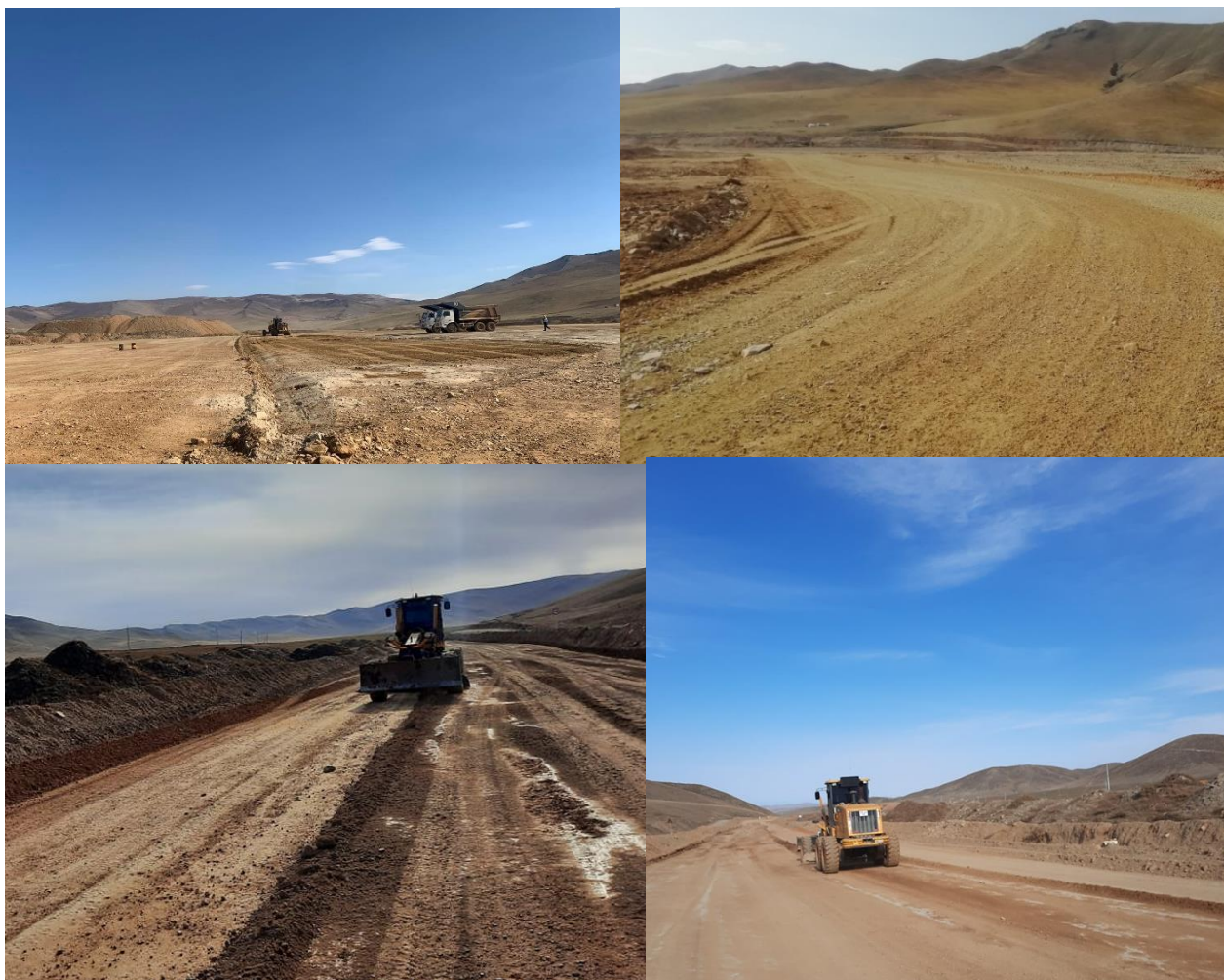
Зураг.3 Тээврийн замд эфелээр дэвсэлт хийж, автогрейдерээр тэгшилэв.
