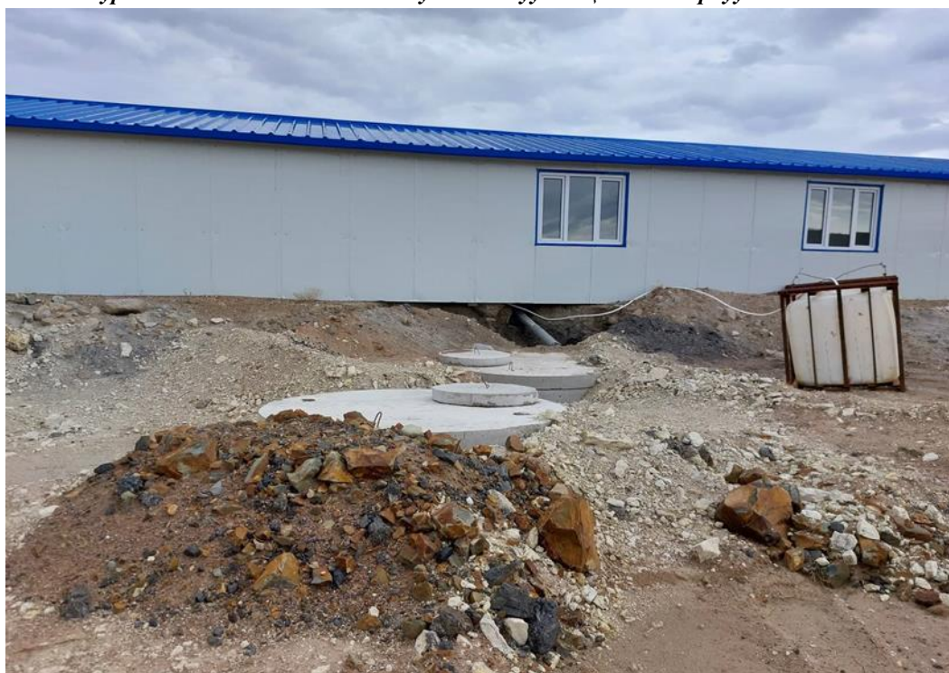
Зураг 15. Нийтийн халуун усны хаягдал усыг зайлуулах цооног байрлуулсан байдал
