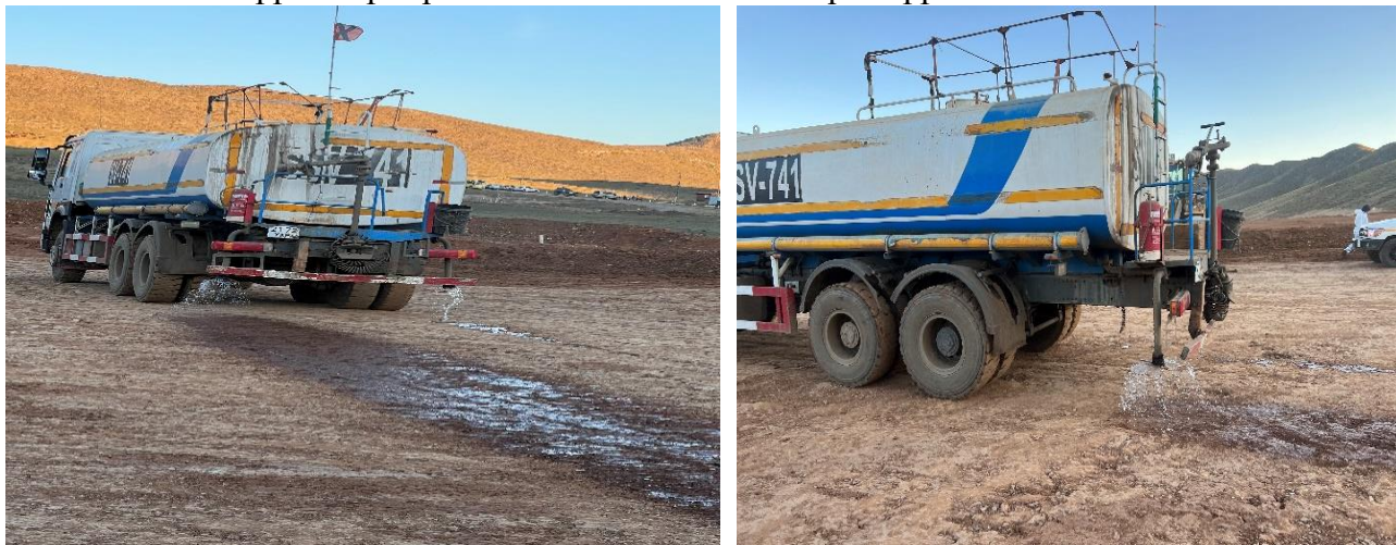
Зураг.4 Уурхайн замд усалгаа хийгдэж буй явц
