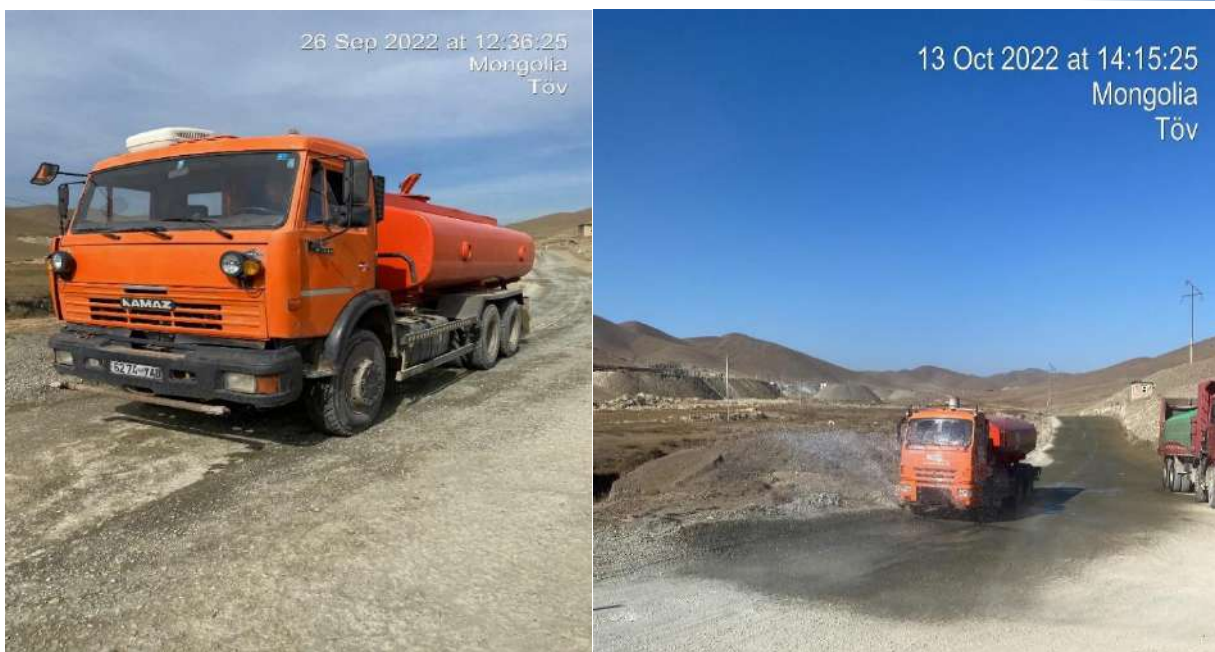
Зураг 2. Тээвэрлэлтийн замыг услаж буй фото зургууд
