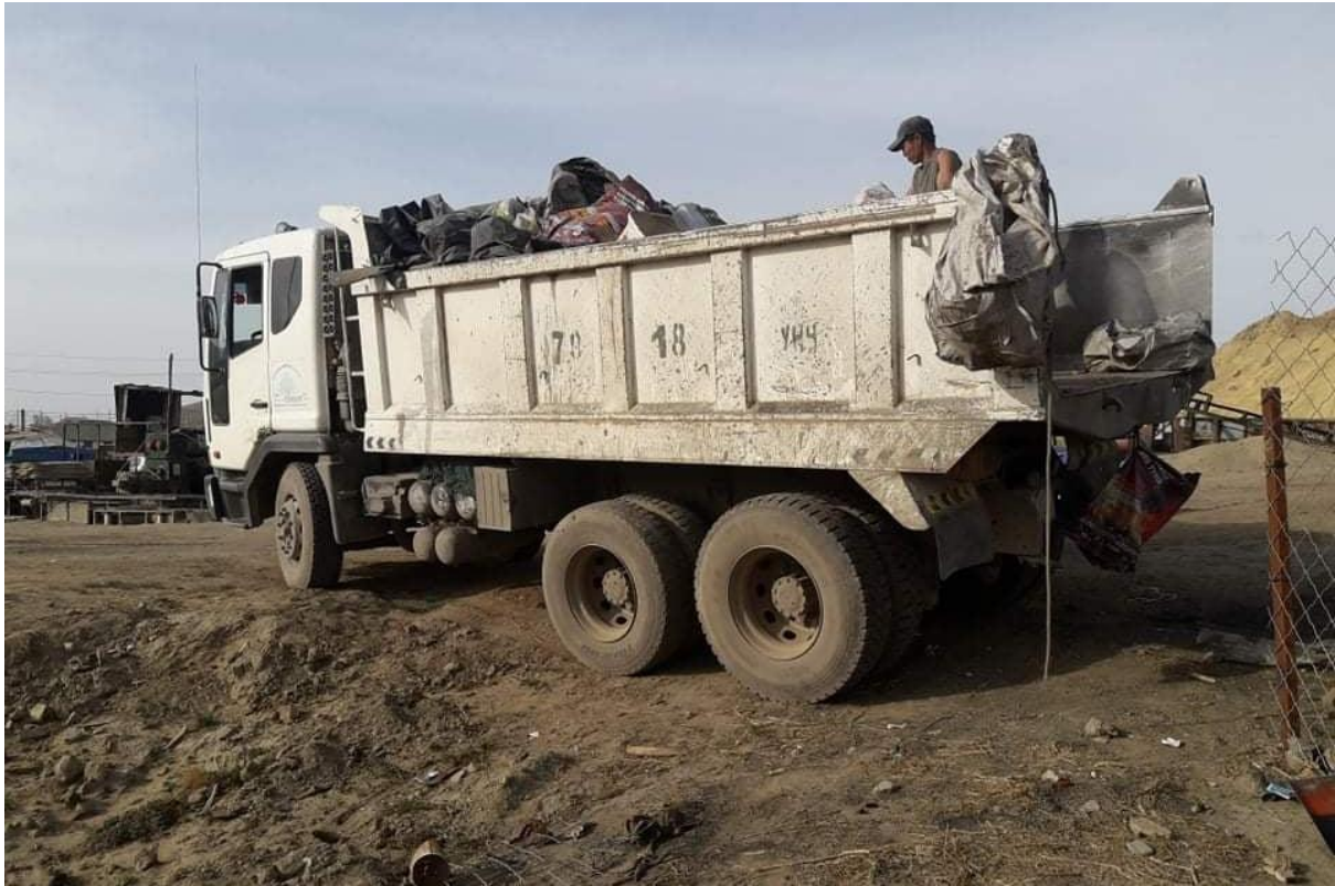
Зураг 19. Төслийн талбай дах хог хаягдлыг тээвэрлэж буй байдал
