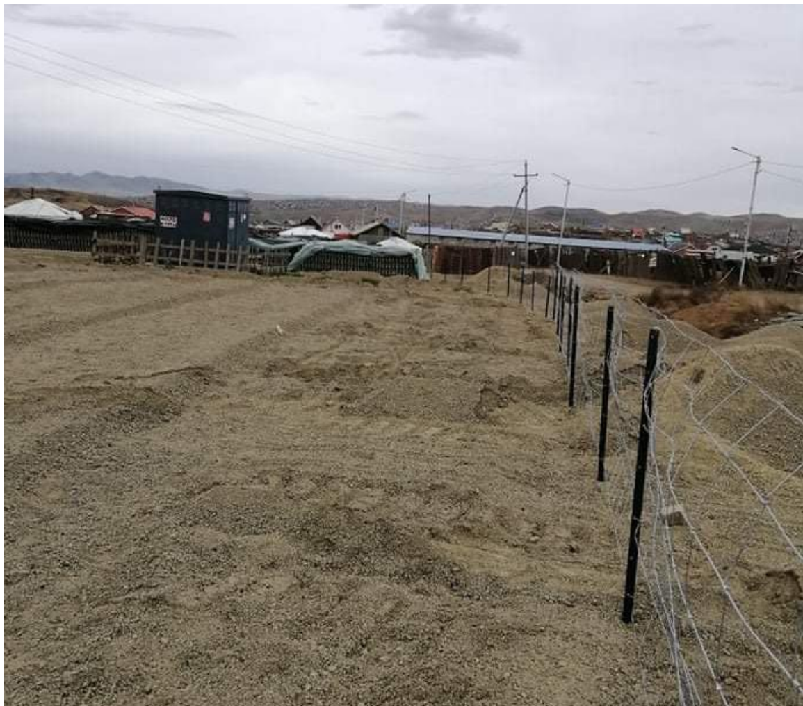
Зураг 7. Техникийн нөхөн сэргээлт хийж талбайг тэгшилсэн байдал
