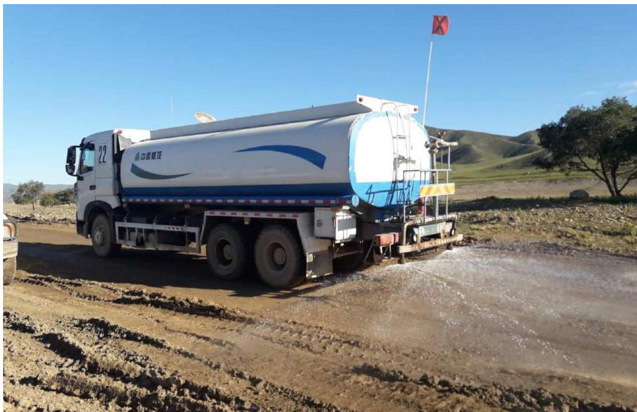
Зураг 2. Замын усалгаа хийгдэж байгаа байдал
