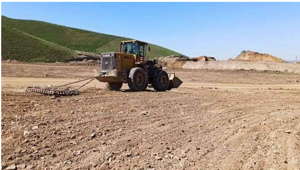
Зураг 8. Техникийн нөхөн сэргээлт хийсэн талбайг БНС-д бэлдэж тэгшилж байгаа байдал
