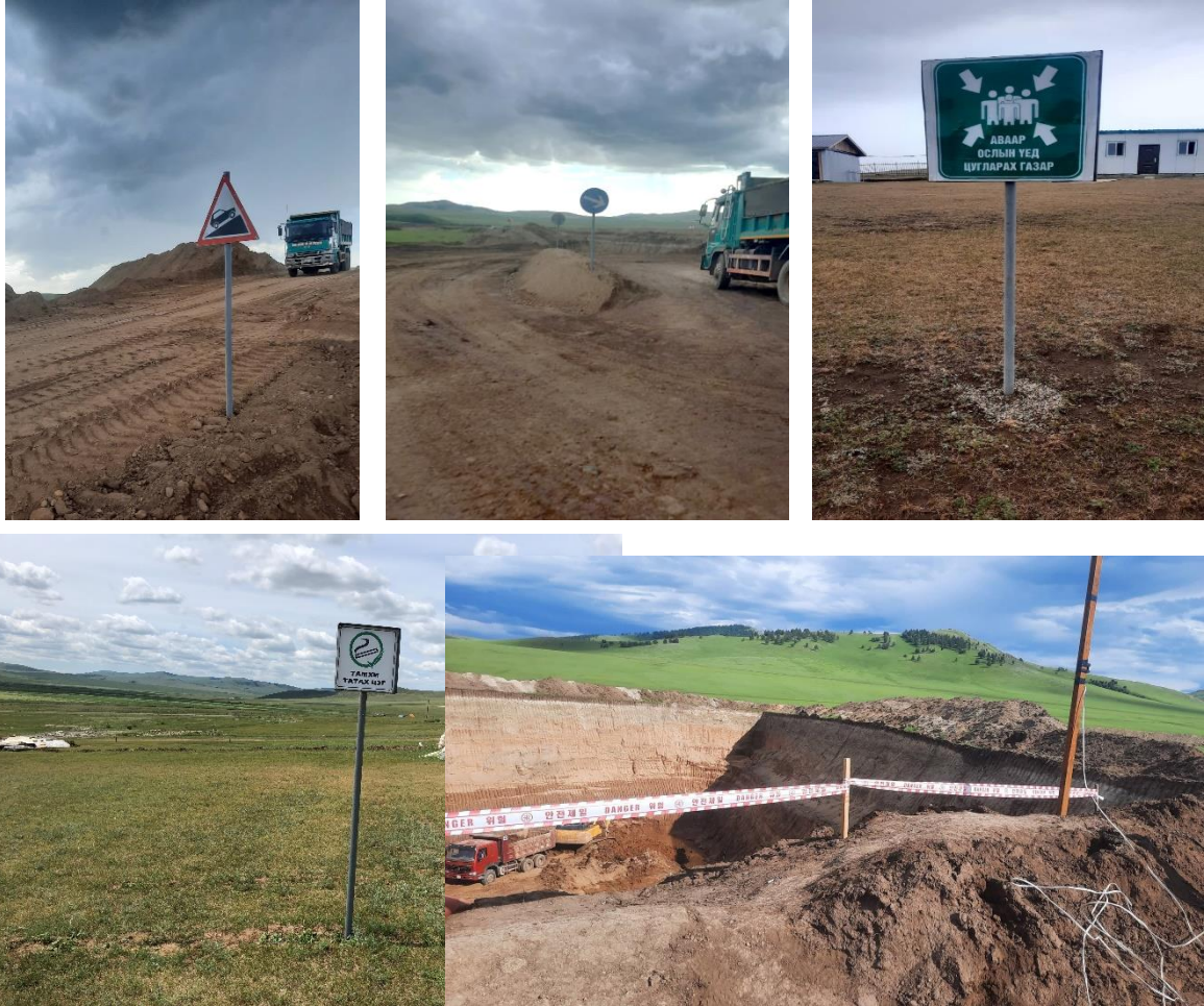
Зураг 7. Замын тэмдэг тэмдэглэгээ байршуулсан байдал
