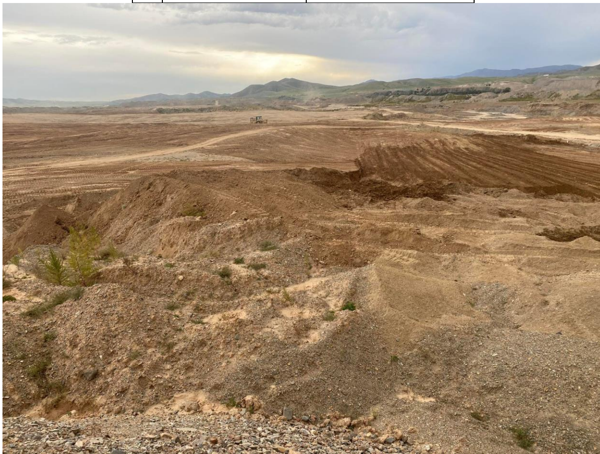
Зураг 16.Нөхөн дүүргэлт хийж буй байдал
