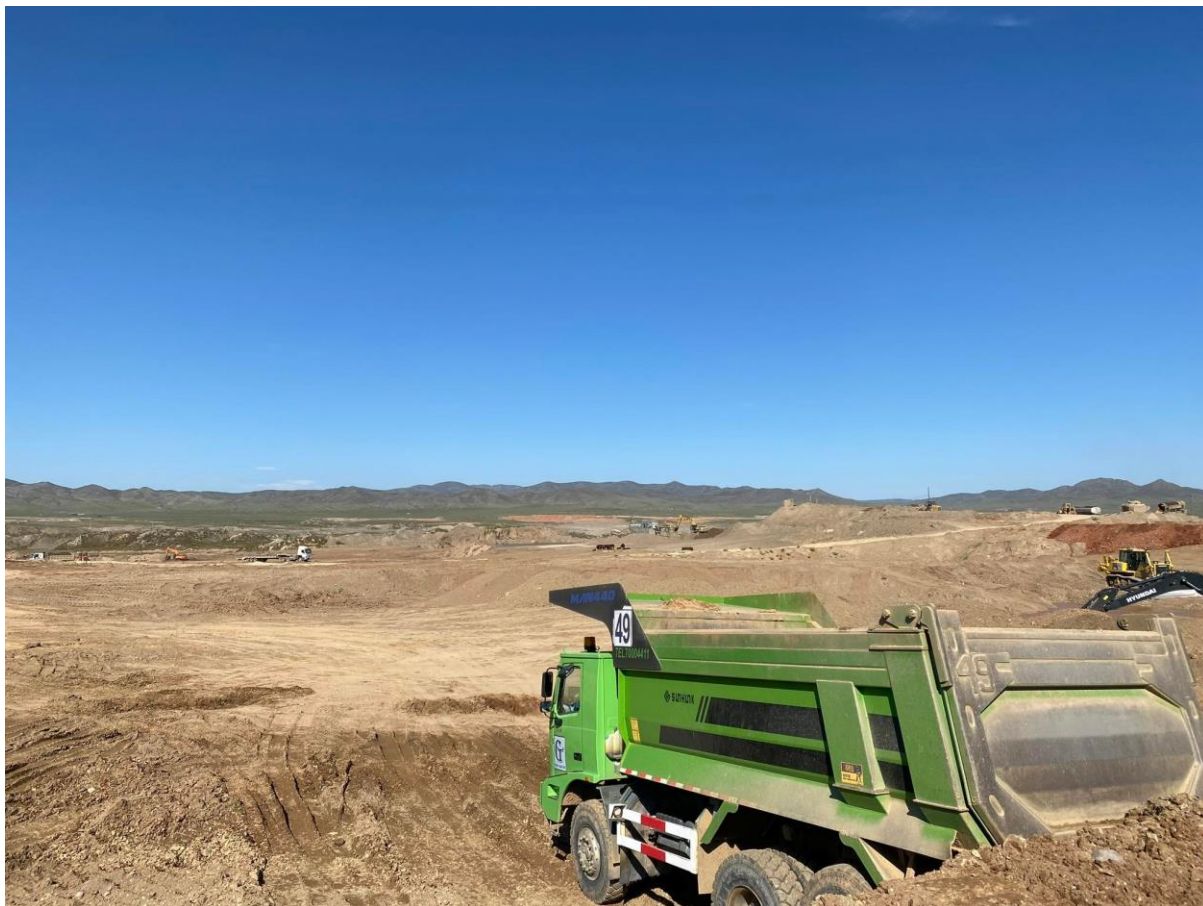
Зураг 19.Нөхөн дүүргэлт хийж буй байдал
