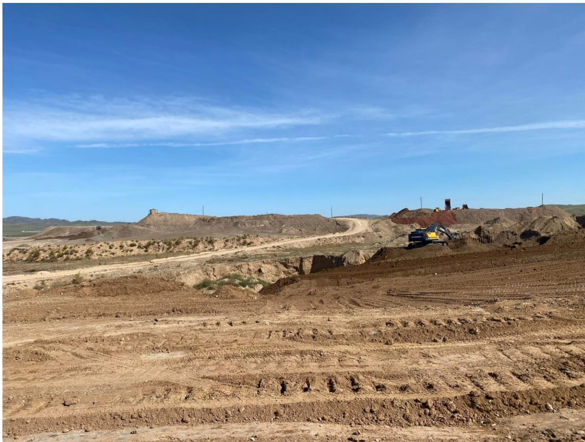
Зураг 21.Нөхөн дүүргэлт хийж буй байдал
