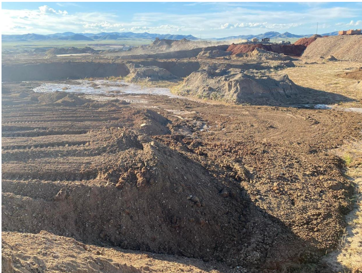
Зураг 17.Нөхөн дүүргэлт хийж буй байдал
