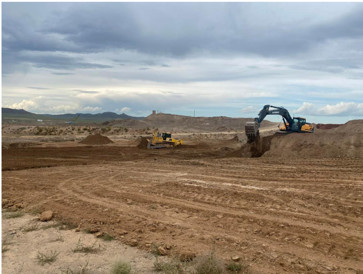
Зураг 18.Нөхөн дүүргэлт хийж буй байдал
