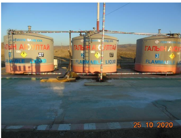
Зураг № 2 - 9. ШТМ-ын асгаралтаас сэргийлж бетонжуулсан байдал
