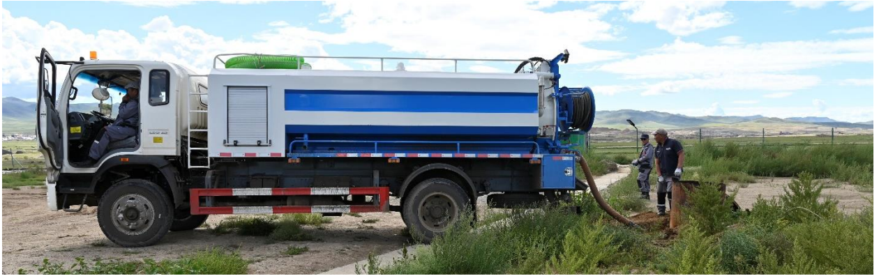
Зураг № 2 - 12. Бохир ус соруулж буй байдал
