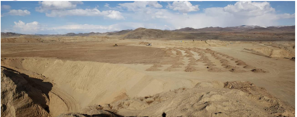
Зураг № 3 - 21. Техникийн нөхөн сэргээлт хийгдэж буй байдал
