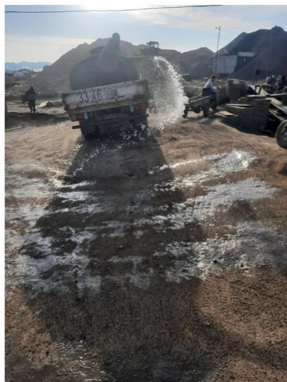
Зураг 4. Үйлдвэрийн орчмын тоосжилтийг бууруулах зорилгоор усалгаа хийжэ буй байдал
