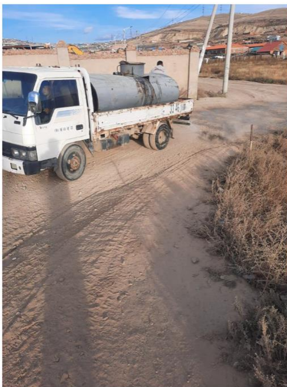
Зураг 3. Гадаад тээврийн замын тоосжилт дарах зорилгоор замын усалгаа хийжэ буй байдал
