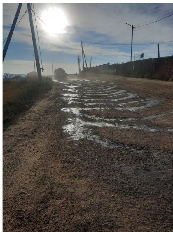
Зураг 3. Гадаад тээврийн замын тоосжилт дарах зорилгоор замын усалгаа хийжэ буй байдал
