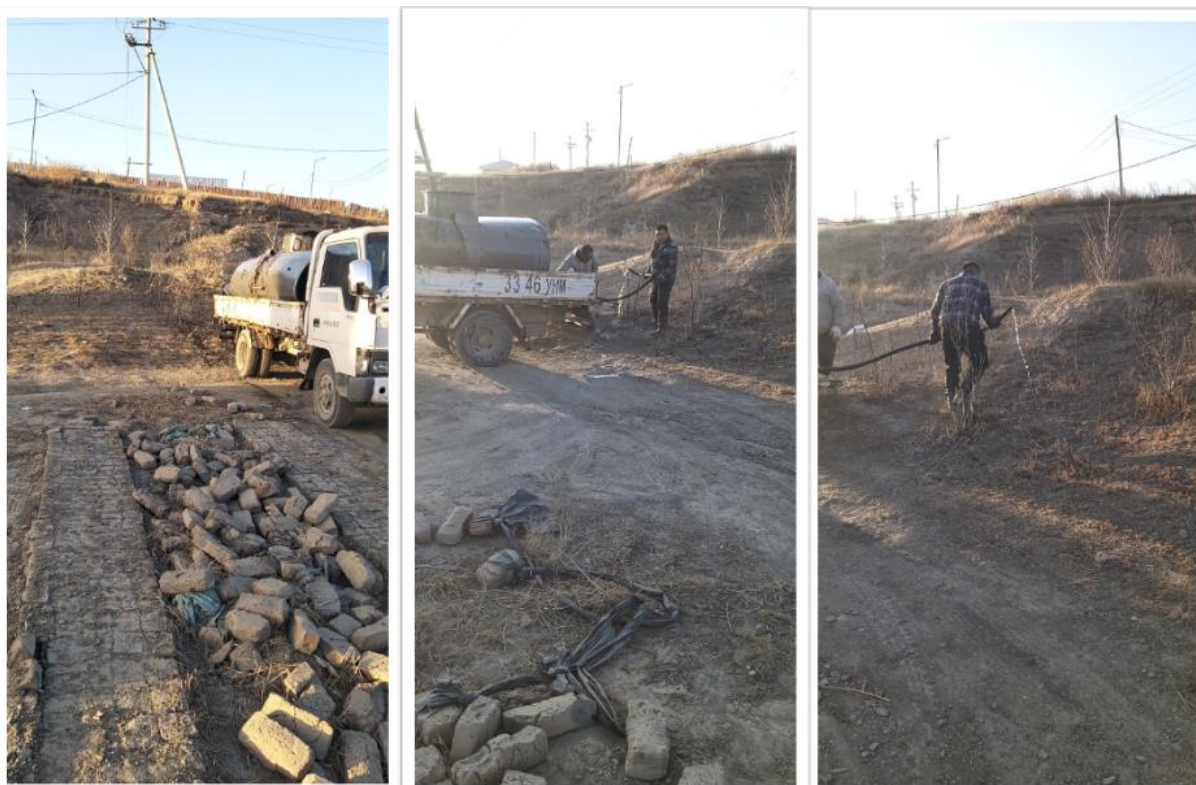
Зураг 10. Төслийн ногоон байгууламжийг услаж байгаа байдал
