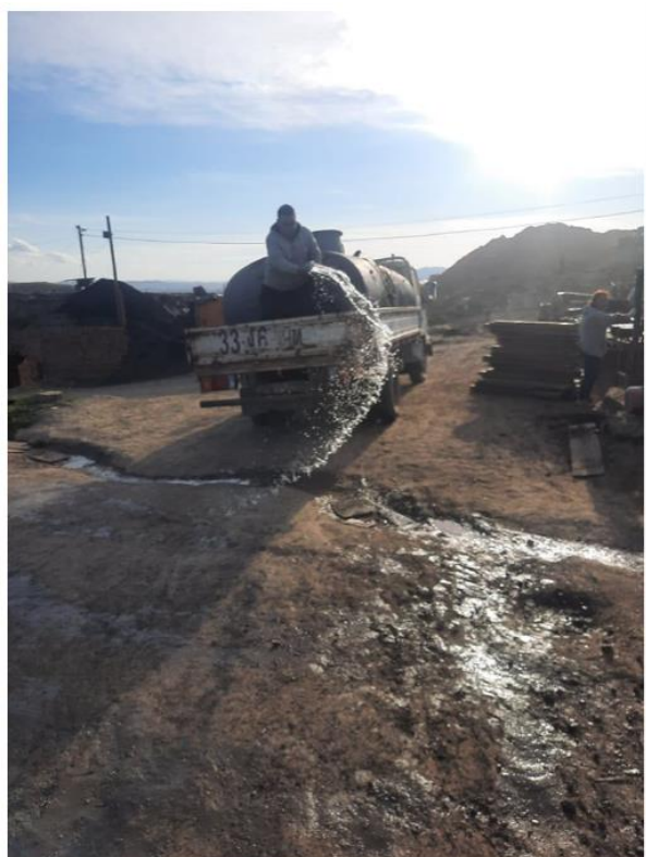
Зураг 4. Үйлдвэрийн орчмын тоосжилтийг бууруулах зорилгоор усалгаа хийжэ буй байдал
