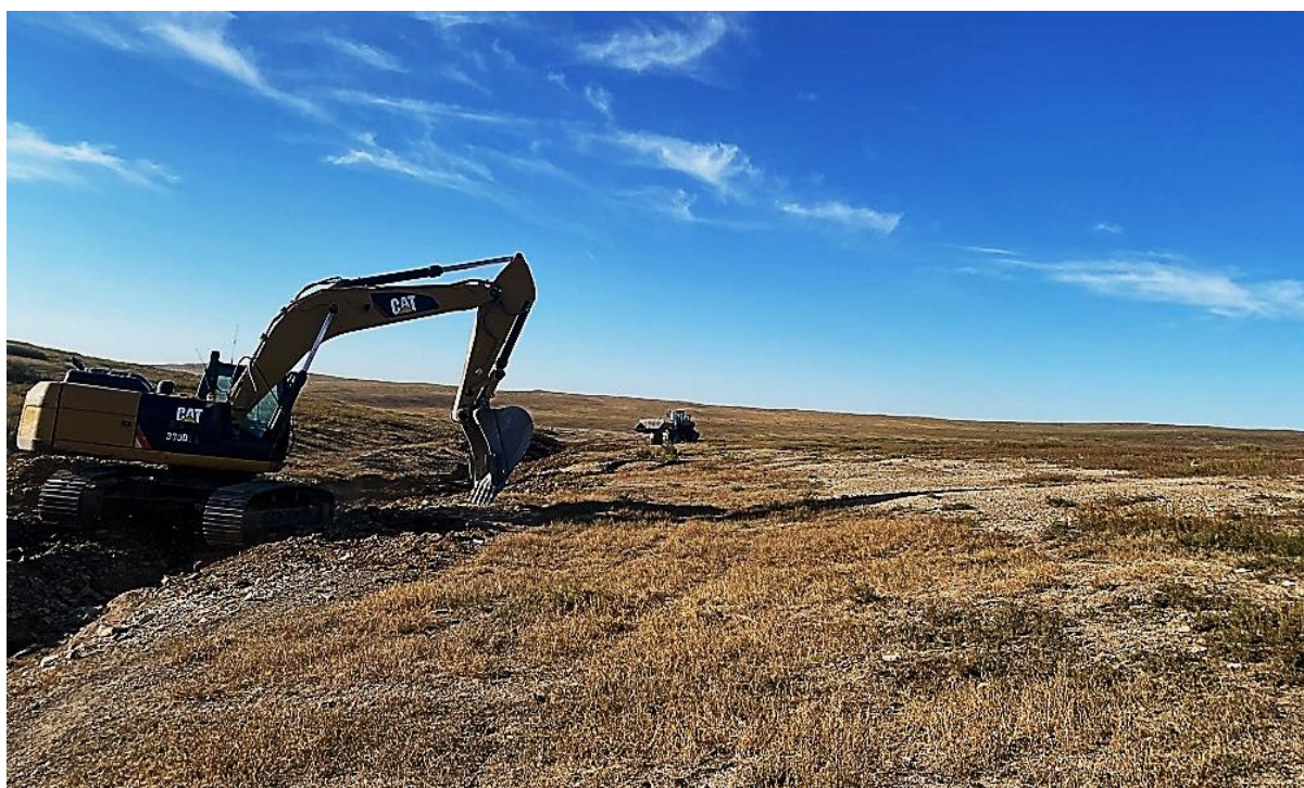
Зураг 5. Талбайд техникийн нөхөн сэргээлт хийж буй байдал
