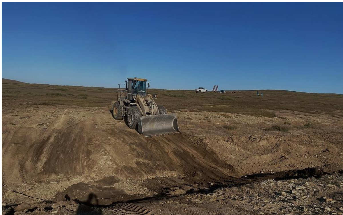
Зураг 5. Талбайд техникийн нөхөн сэргээлт хийж буй байдал
