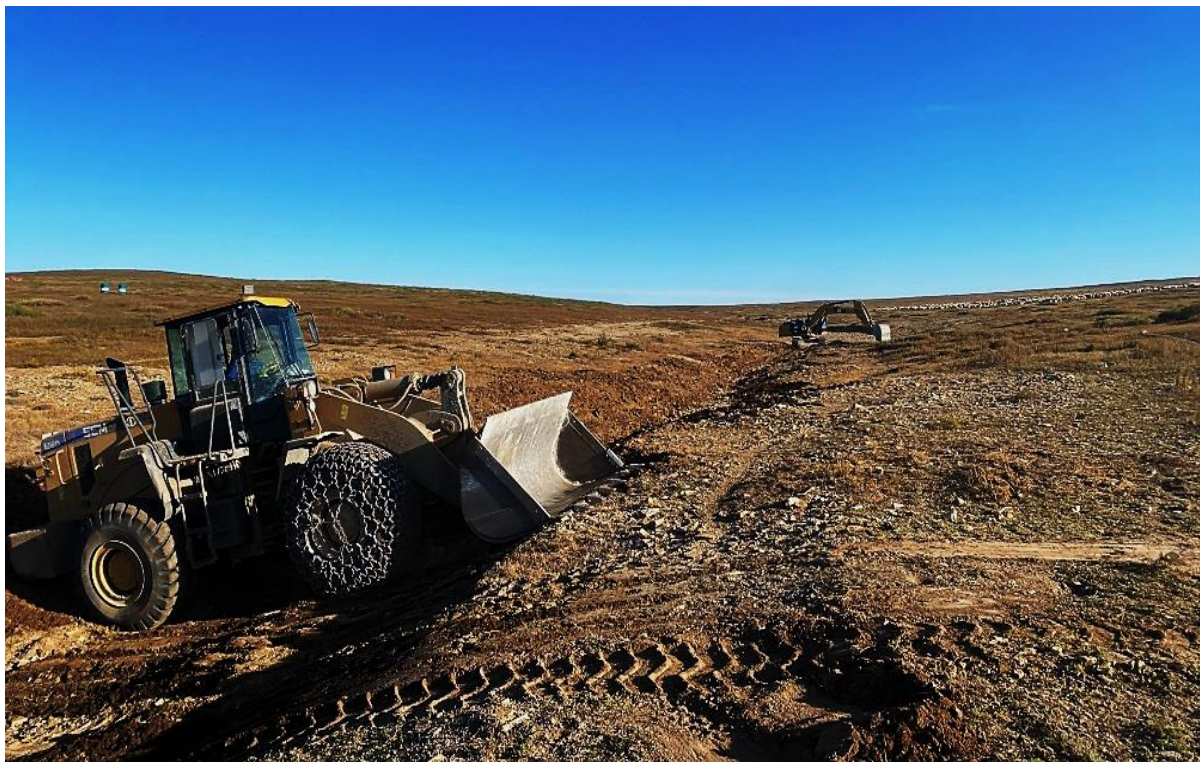
Зураг 6. Талбайд техникийн нөхөн сэргээлт хийж буй байдал
