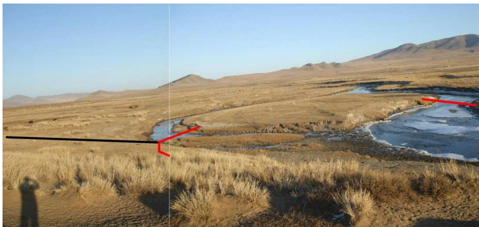
Фото 15. Дөхүүлэх сувгийн эхлэлийн трасс, усны түвшин өргөх хоёр габионы хөндлүүрийг үзүүллээ.
