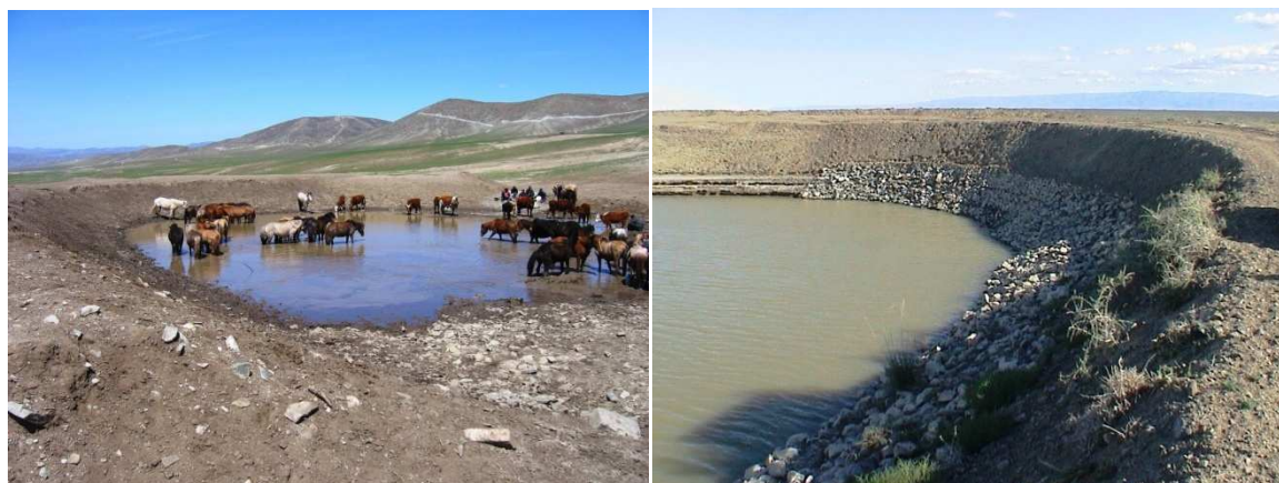
Фото 6. Шороон боомт байгуулан бичил цөөрөм үүсгэн ашиглаж байгаа байдал (фотог Л.Ж.)
