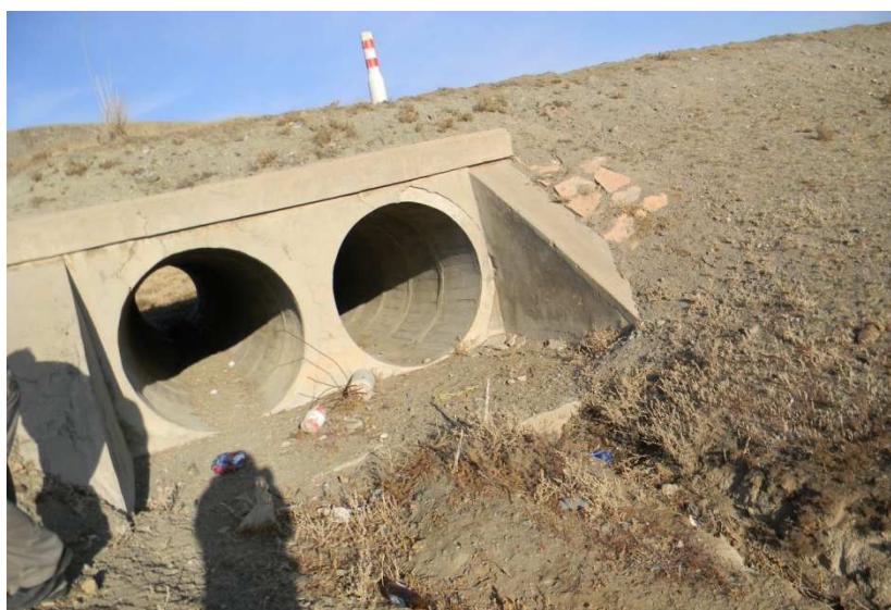
Фото 20. Зам доогуурх үерийн ус гаргах хос хоолой
