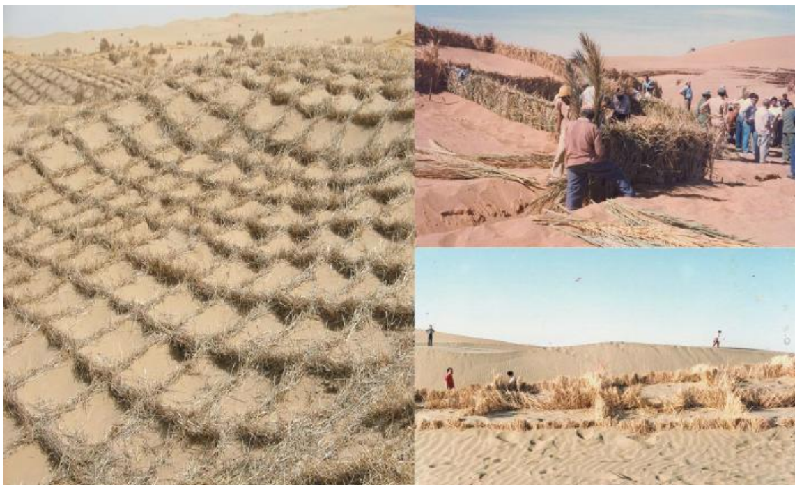
Зураг 9. Хуурай газар нутаг дахь элсний нүүдлийг зогсооход ургамлын хэсгүүдийг өөр өөр загвараар ашиглаж буй байдал (гол төлөв дал модны навч)
