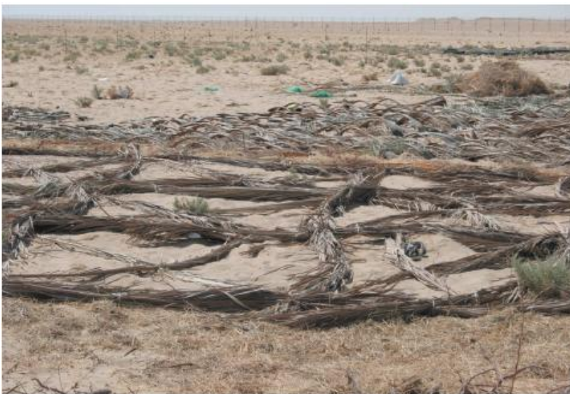
Зураг 8. Ал-Лияхын газрын элсийг тогтворжуулахад дал модны навчны өөр өөр хэсгийг ашиглах нь, 2006 оны 8 дугаар сар
